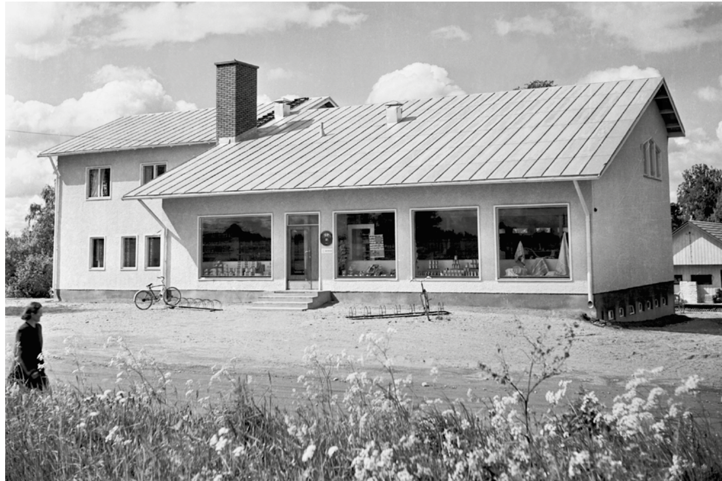
Kuva 11 Osuuskaupparakennus vuonna 1956 valmistumisensa jälkeen. Kuvalähde Ristina-seura, valokuvaaja Olli Kervinen.
