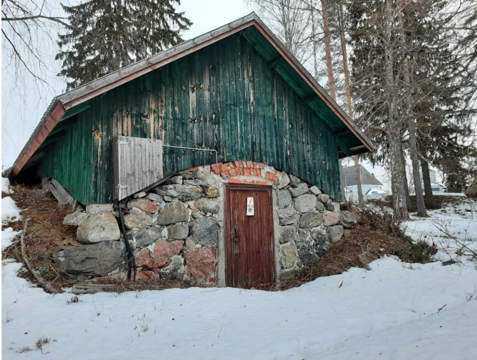
Kuva 4. Yksi kolmesta suunnittelualueen venesataman edustalla olevista vanhoista rantakellarirakennuksista, joiden ulkoasu on tarkoitus suojella asemakaavamuutoksen yhteydessä. Kuva otettu venesataman suunnasta.
